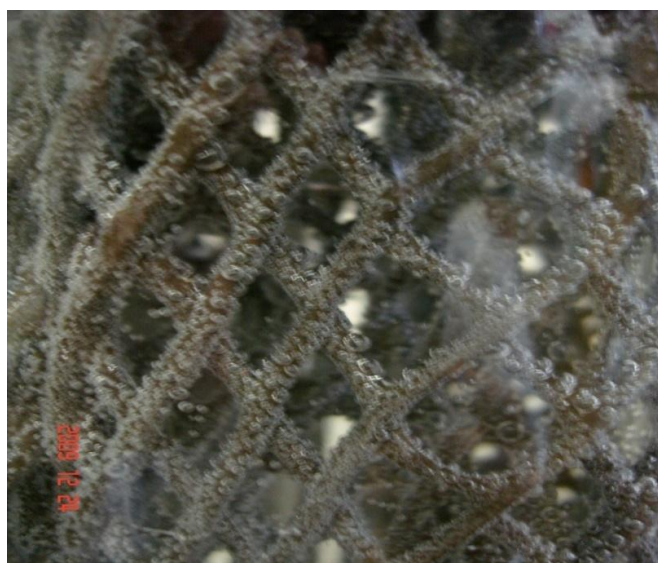
Рис.1. Вид каталитических блоков в аэротенке.
